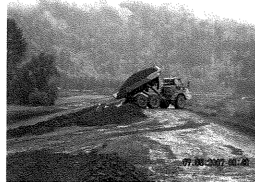
51+00 DUMPING BASE MATERIAL
