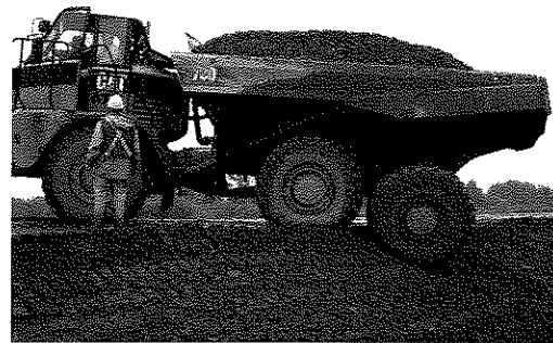
51+00 DUMPING BASE MATERIAL
